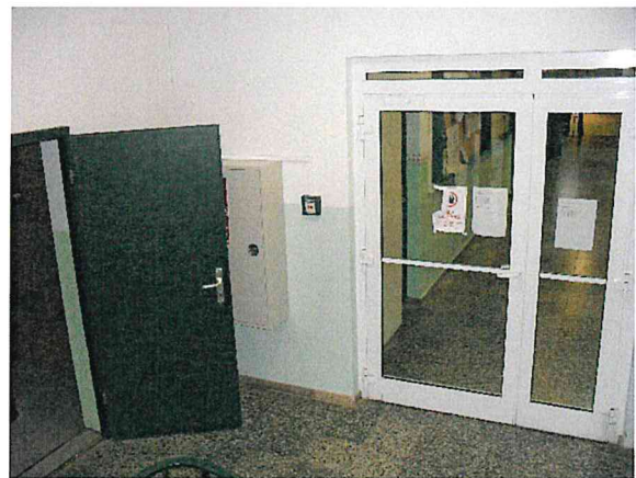
F4: Tür zu notwendigem Treppenraum/ Kochküche
