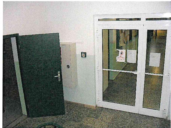
F4: Tür zu notwendigem Treppenraum/ Kochküche
