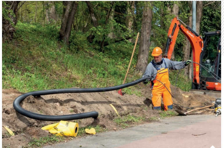
Tiefbaufacharbeiter Henri Koschke verlegt das Steuerkabel für die Lichtsignalanlage an einer Straßenkreuzung in Schwerin.
