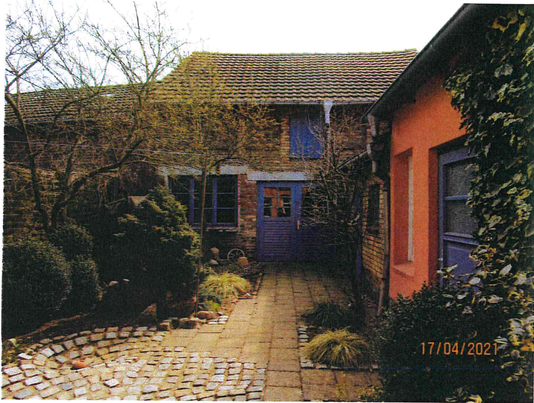
Fritz-Reuter-Straße 21, Crivitz Nebengebäude (alte Tischlerei) Hofansicht
