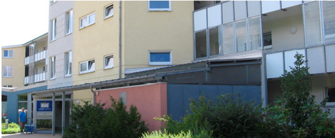
Abbildung: Seniorenwohnanlage, Lise-Meitner-Str. 15, Schwerin 6
