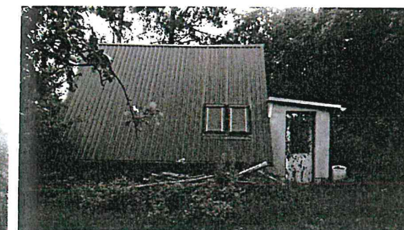
Ist-Zustand der Finnhütte
