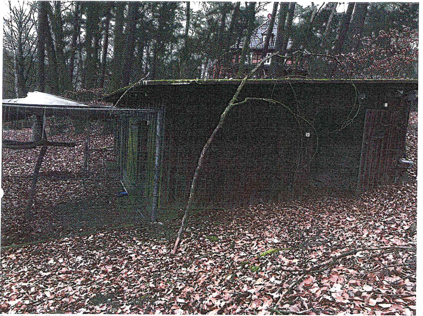
Der alte Stall / Schuppen. Strom/Kraftstrom liegt an. Im Hintergrund das Wohnhaus.
